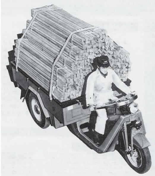
オート三輪車は、戦後もしばらくは幌もなく荷物を積むだけで走行していた。それでも長尺ものを積める荷台になっていることが必要だった。これはマツダLB型でエンジン排気量701cc750kg積みだった。
