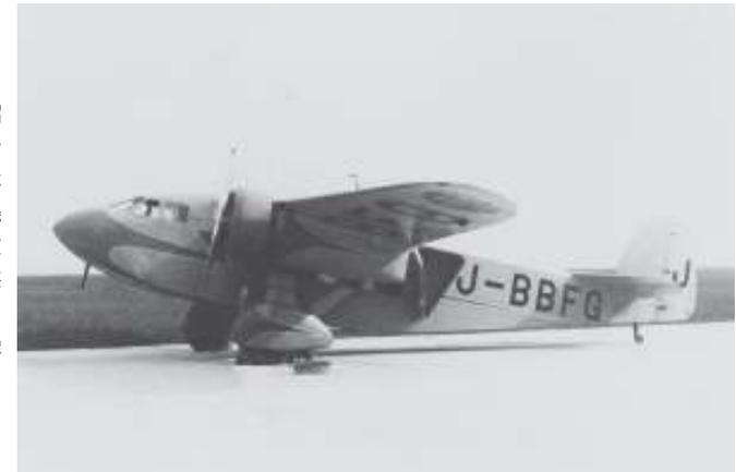
滑走路のない不整地でも運用可能なように短距離離着陸(STOL)性能を備えた三式指揮連絡機。空中指揮、着弾観測、偵察などを任務とした。Fi156シュトルヒ(ドイツ フィーゼラー社)との比較審査の結果、制式採用された。比較審査時における離着陸距離は離陸58m、着陸62mでFi156シュトルヒを上回った。(提供:日本航空協会)
