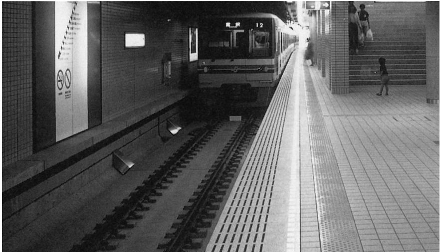
地下鉄に多いコンクリート道床軌道（仙台市営地下鉄）。
